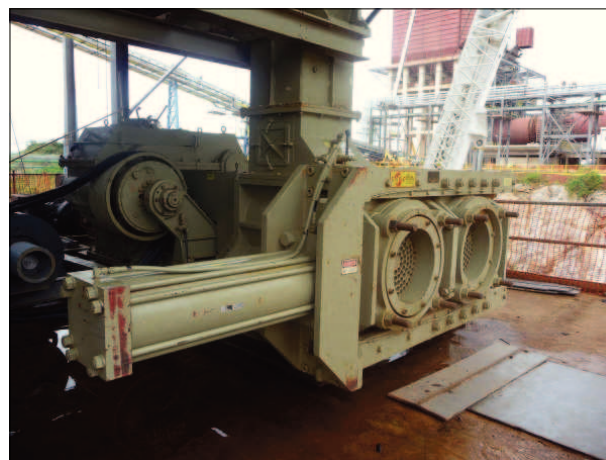
Рис. 2. Монтаж оборудования Steele в Бразилии на предприятии VALE (Mineracao Onca-Puma)
