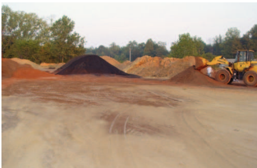
Рис. 2. Подготовка шихтовых материалов для изготовления брэксов
